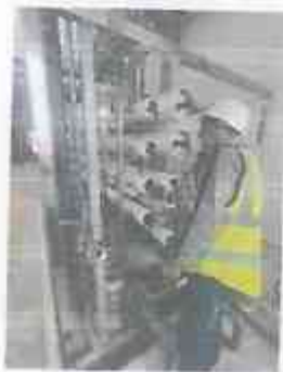
★1 反渗透系统出水
