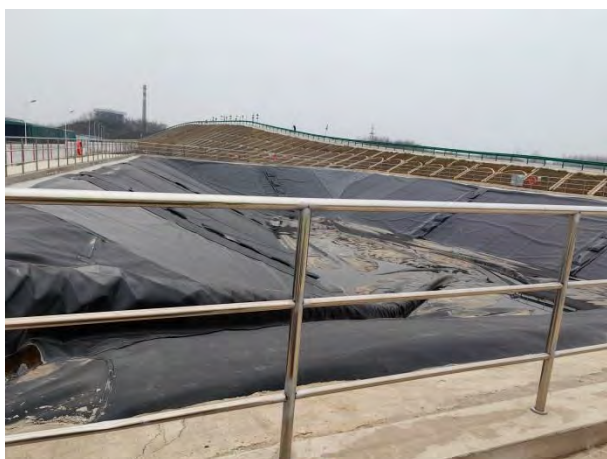
渗滤液收集池
