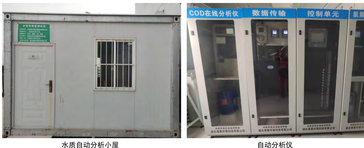
图 5-7 排污口及自动监控设施照片
